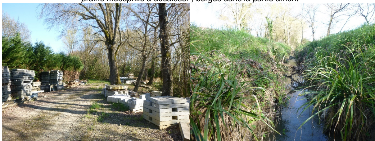
Remblais à décaisser : berges abruptes et touffes de Laïche pendante
